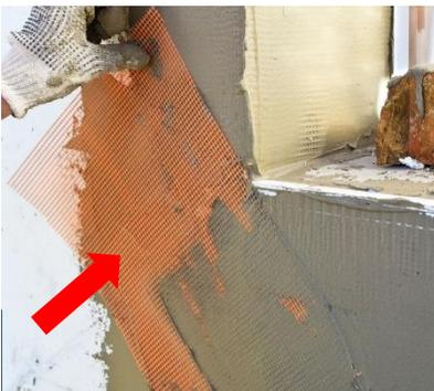
In corrispondenza degli angoli dell'edificio da coibentare o di aperture per porte e finestre è necessario utilizzare opportuni rinforzi angolari per cappotto per preservare gli spigoli da urti e colpi, inoltre in prossimità degli spigoli di aperture per porte e finestre, è utile installare porzioni di rete per cappotto disposta a 45° per limitare le fessurazioni e tensioni trasversali.
