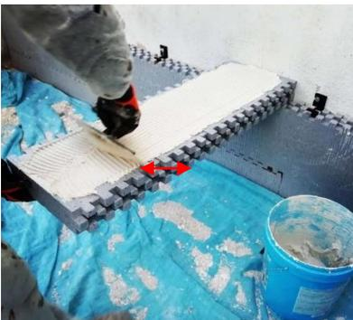
**Procedere con la stesura della colla direttamente sul retro dei pannelli** a spatola dentata (foto B), avendo cura di non sporcare gli incastri degli stessi. Posando il cappotto su pareti particolarmente lisce, si potrà optare per l'incollaggio mediante schiuma poliuretanic; viceversa se la superficie sarà particolarmente scabra e con avvallamenti, potrà essere necessario procedere con incollaggio a cordolo perimetrale e punti (Foto A) per livellare la superficie.
