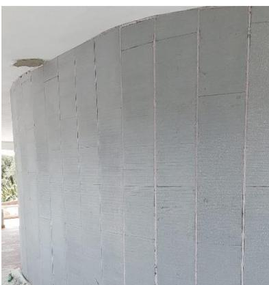
Nel caso di installazione su pareti curve suggeriamo di posare i nostri pannelli in senso verticale, per seguire più facilmente l'andamento curvilineo della stessa. Sigillare poi mediante schiuma isolante le giunture e successivamente grattonare leggermente per raccordare la superficie di unione.
